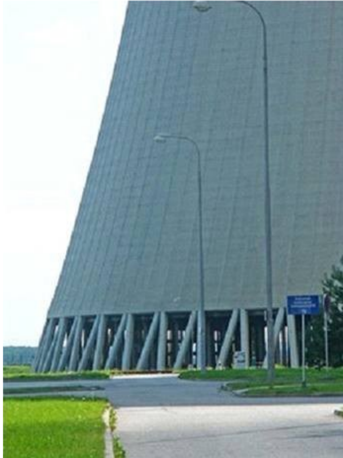
Prostor pro nasávání vzduchu do chladicí věže
