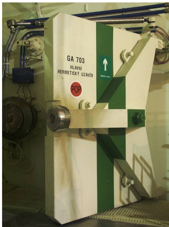
Hermetický vstup do kontejnmentu
