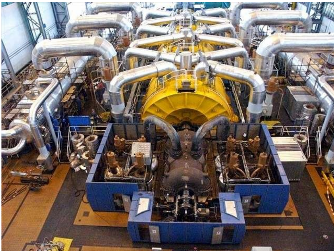
Turbína ETE (v popředí vysokotlaký díl, v pozadí nízkotlaké díly, po stranách jsou přehříváky páry)
